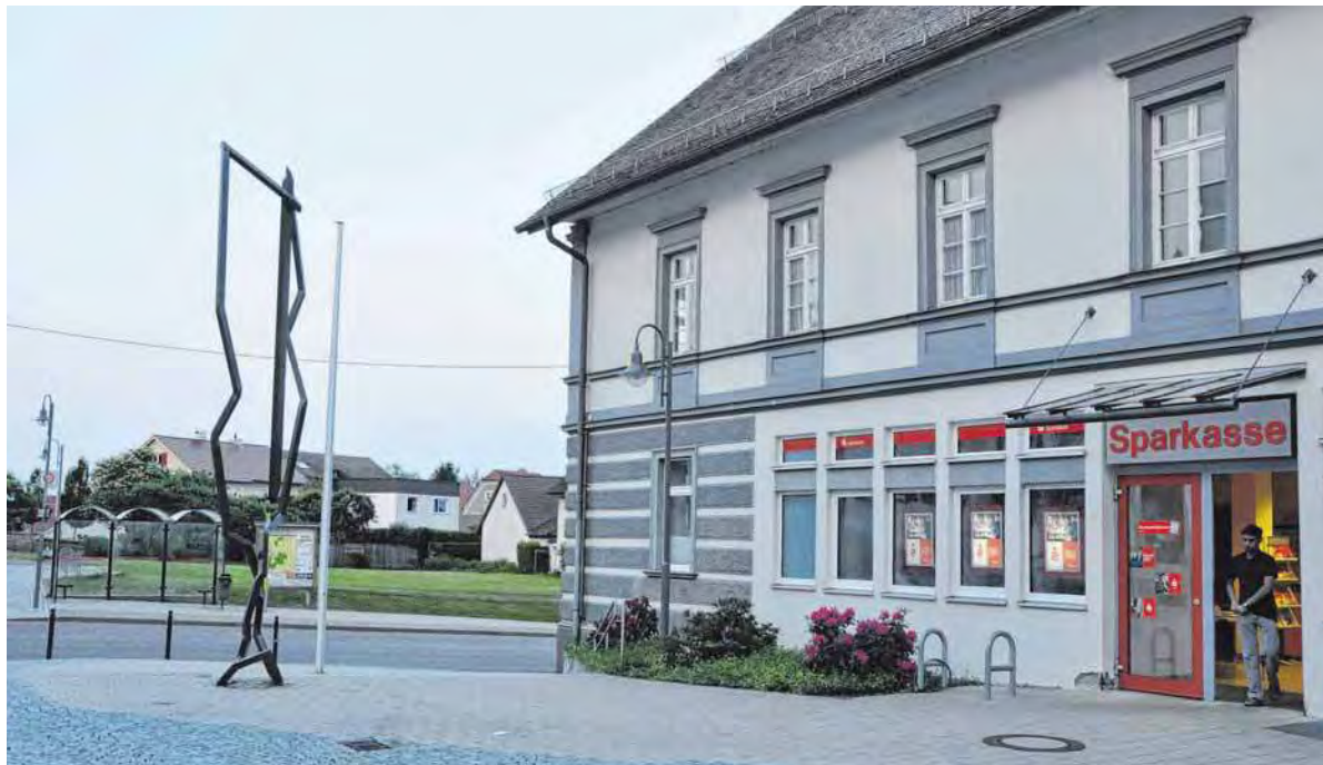
Auf der Wiese gegenüber der bestehenden Sparkassenfiliale soll das neue Gebäude entstehen. FOTO: BARBARA BAUR
