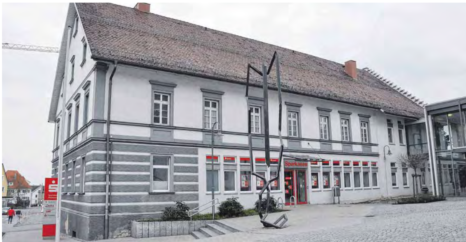
Die Statik des Sparkassengebäudes reicht nicht für einen Bürgersaal im Obergeschoss. Es wird abgerissen.
