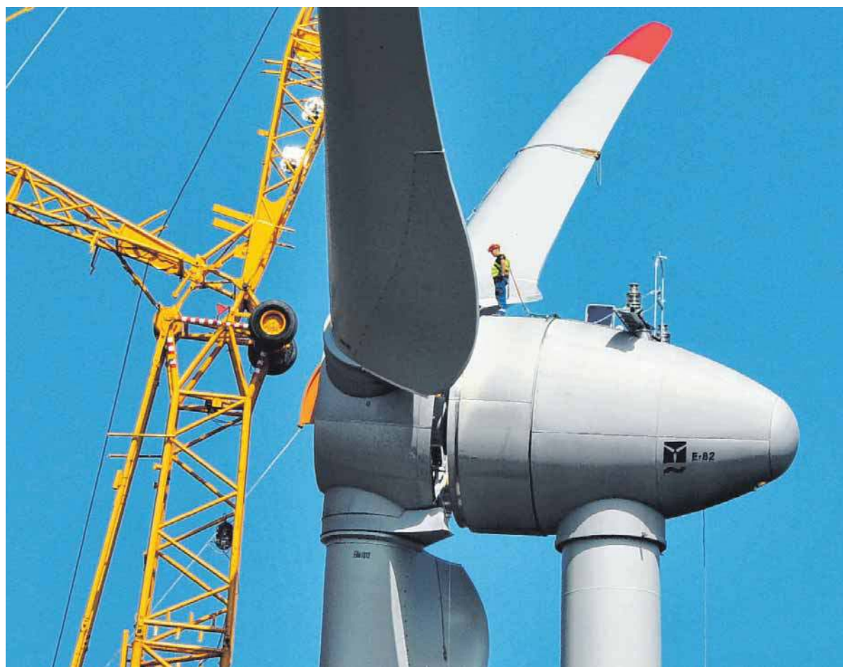
Arbeiten an einer Windkraftanlage auf dem baden-württembergischen Scheerberg bei Freiamt-Ottoschwanden (Kreis Emmendingen): Ökologisches Wirtschaften ist ein Kriterium für eine nachhaltige Geldanlage. FOTO: DPA
