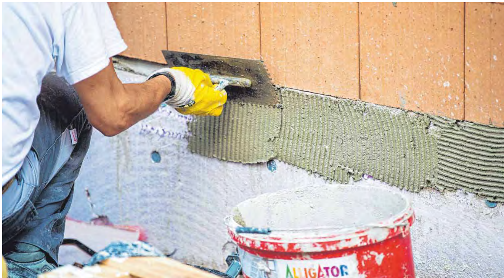
Handwerker bei der Befestigung des Mauerfußes: Eine Faustregel besagt, dass Bauherren nicht mehr als 40 Prozent des monatlich verfügbaren Einkommens für ihre Hausfinanzierung aufwenden sollten.
